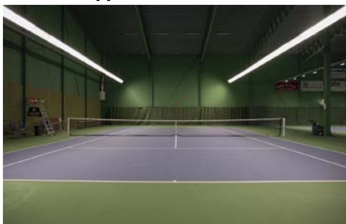
44st Lysrörsarmaturer 3x58W 9,4 kW • 400 Lux • 65% Jämnhet
