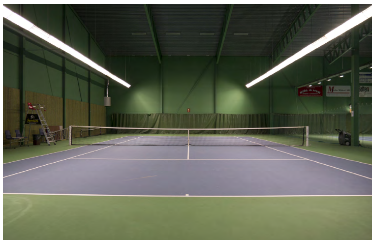
44st Lysrörsarmaturer 3x58W 9,4 kW • 400 Lux • 65% Jämnhet
