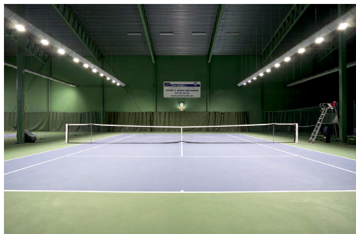
22st HAWKEYE LED 103W 2,3 kW • 550 Lux • 90% Jämnhet
